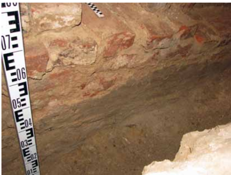
Il. 13. Zamek w Kórniku. Pomieszczenie 13, południowy fundament odkrytej konstrukcji murowanej. A – zachodnia partia fundamentu z odchodzącą przyporą – widok ze wschodu. B – pozostałości tynku na południowym licu fundamentu. Fot. Małgorzata Andrałojć
