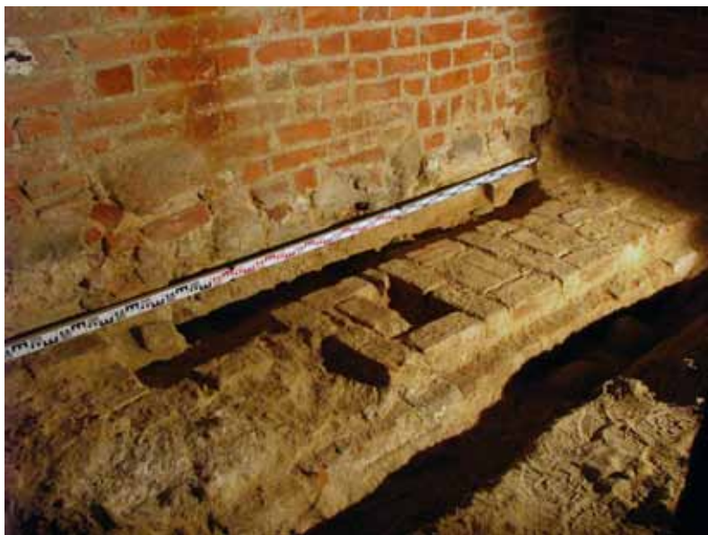
Il. 11. Zamek w Kórniku. Pomieszczenie 20, wschodnia część odkrytej konstrukcji murowanej z posadowioną na niej gotycką ścianą pomiędzy pomieszczeniami 13 i 20. A – pełny mur na fundamencie z odsadzką w części południowej; widoczny brak łączenia fundamentu z fundamentem południowym pomieszczenia 20 – widok ze wschodu. B – wychodząca z pełnego muru ściana na fundamencie z odsadzką w części centralnej i północnej – widok z południowego wschodu. Fot. Małgorzata Andrałojć
