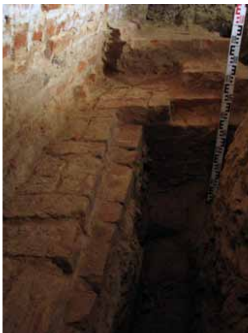
Il. 14. Zamek w Kórniku. Pomieszczenie 13, zachodnia część fundamentu i ściany odkrytej konstrukcji murowanej z ciągiem komunikacyjnym z posadowioną na niej gotycką ścianą pomiędzy pomieszczeniami 13 i 20. A – widok z zachodu. B – widok z północy. Fot. Małgorzata Andrałojć
