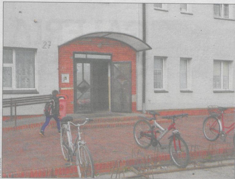
Budynek od lat jest dewastowany
