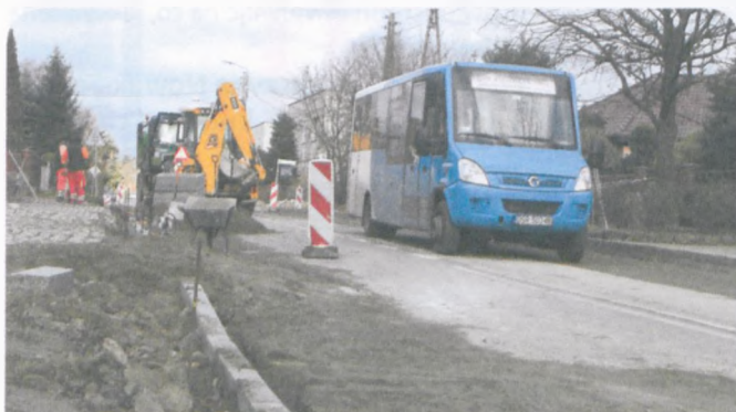
Prace na ul. Sobieskiego.
