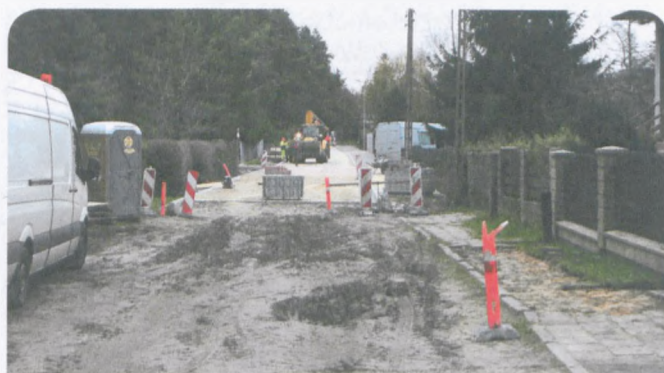
Prace na ul. Mazurskiej.
