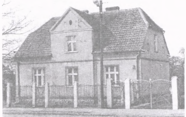
Dom przeznaczony do wyburzenia
