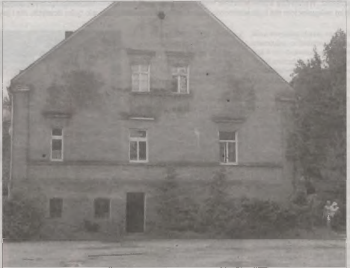
Dwór w Dobrej wymaga generalnego remontu. Dohrze, że władze gminy zdecydowały się na przywrócenie tego obiektu społeczności. Ale niewątpliwie trudno będzie wykonać ten remont w planowanym przez burmistrza terminie.
