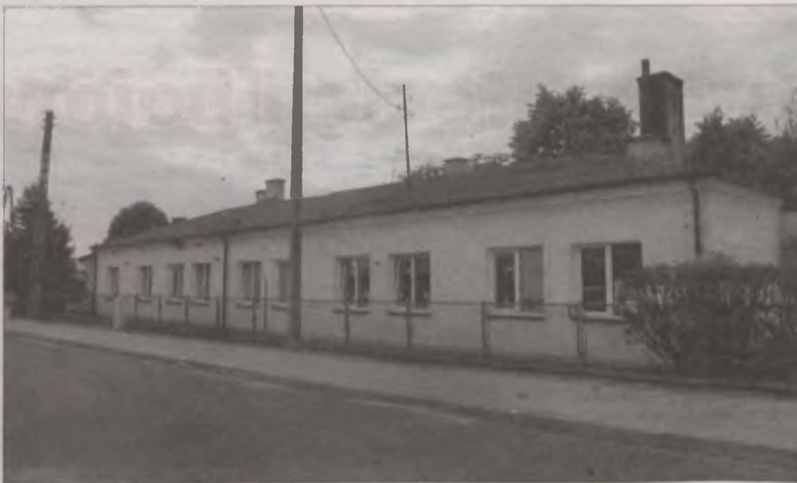
Obecny budynek przedszkola nie jest w stanie pomieścić wszystkich dzieci.
