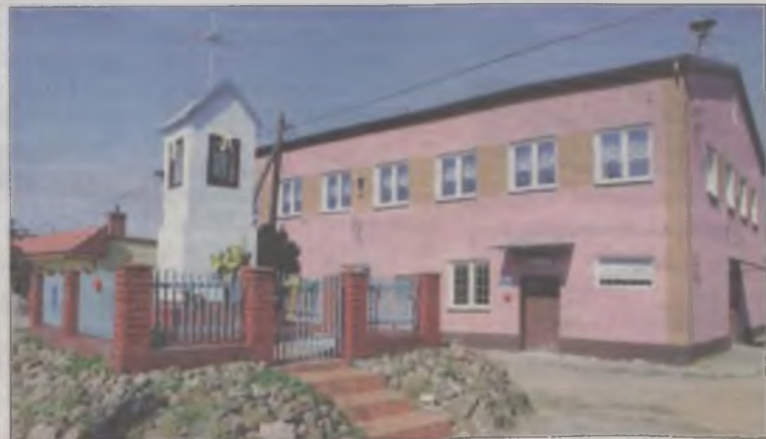
Świetlica i siłownia mają powstać na parterze remizy.
