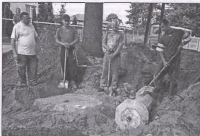
Fundament oraz cokół odkopano we wskazanym miejscu
