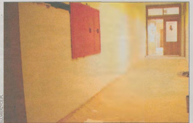
Prace remontowe trwają
