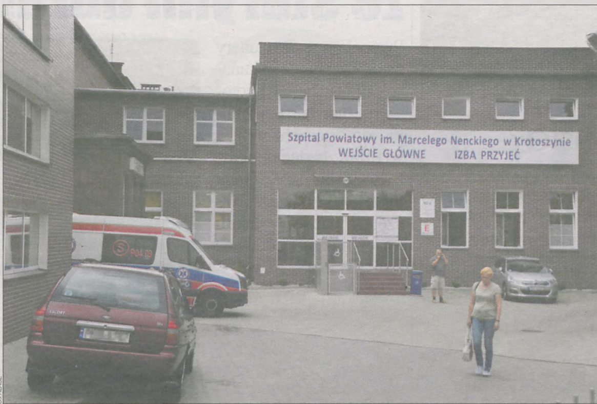
Szpital czeka na dokumentację rozbudowy
