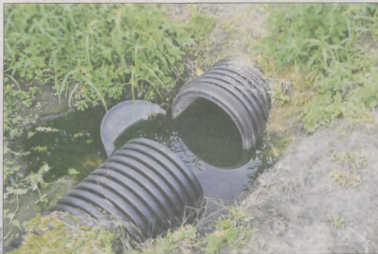
Tutaj ma być zamontowana studzienka
