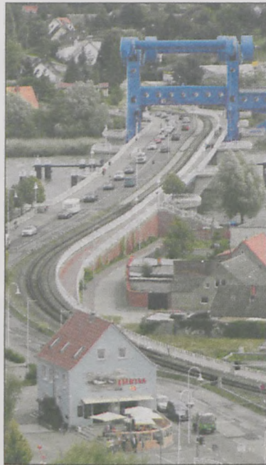
Zwodzony most kolejowo-drogowy w niemieckim Wolgast
