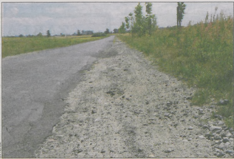
Od tego miejsca pobocze będzie modernizowane
