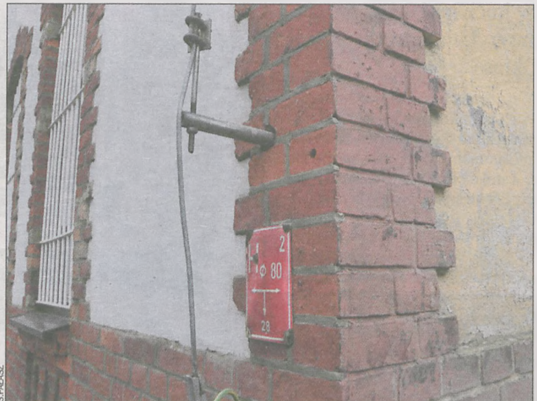
Po lewej fragment nowego podkładu pod elewację, wykonany w ub. roku
