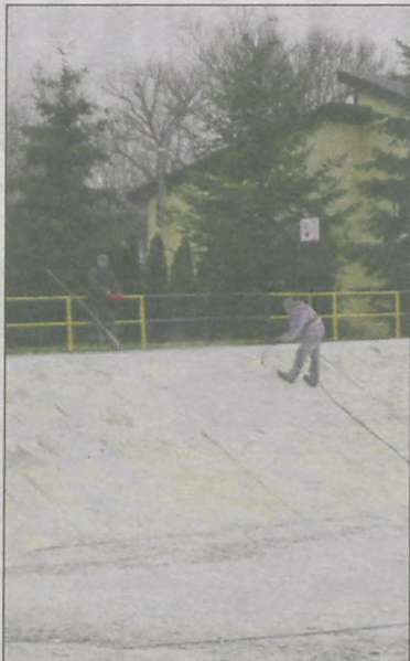
Trwają niezbędne prace modernizacyjne
