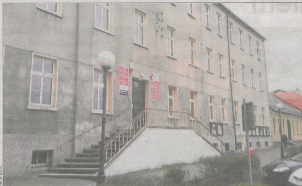
Winda zostanie zamontowana za budynkiem
