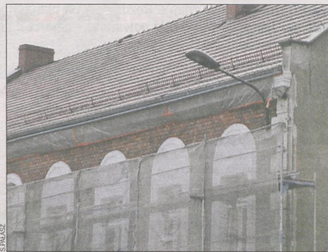
Remont budynku komunalnego w toku
