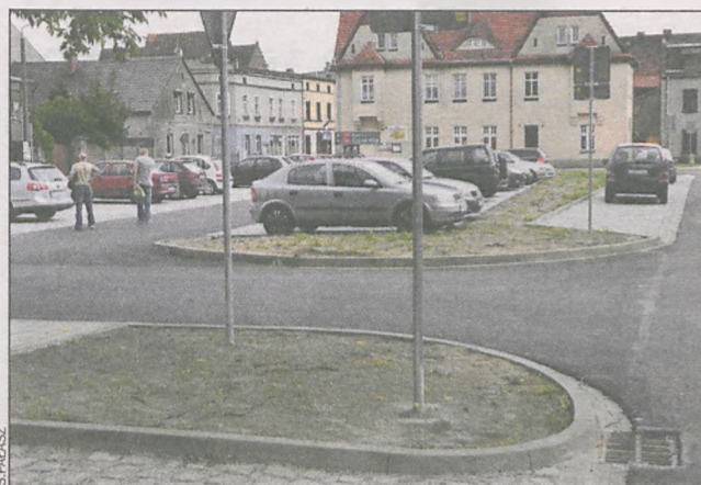
Teraz ulica wygląda zupełnie inaczej niż przed przebudową
