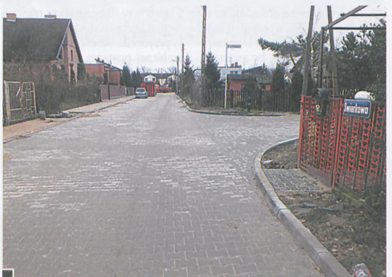
W ramach inwestycji utwardzono i wyposażono w deszczówkę również sąsiednią ul. Świerkową (109. miejsce w hierarchizacji ulic) wraz z jej ślepą odnogą – ul. Wrzosową z placem do manewrowania (47. miejsce w hierarchizacji). Włot w tę ulicę jest widoczny na zdjęciu po prawej, w głębi ul. Westerplatte. Świerkowa otrzymała ponadto jednostronny chodnik fot. Hanna Siatka
