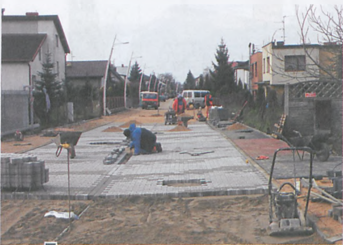
Firma „Tar-Drog” z Tarnowa Podgórnego podczas układania jezdni i chodników ul. Westerplatte (jezdnia – jasnoszara kostka pozbrukowa, chodniki – ciemnoszara, wjazdy na posesje – ciemnoszara) fot. Hanna Siatka
