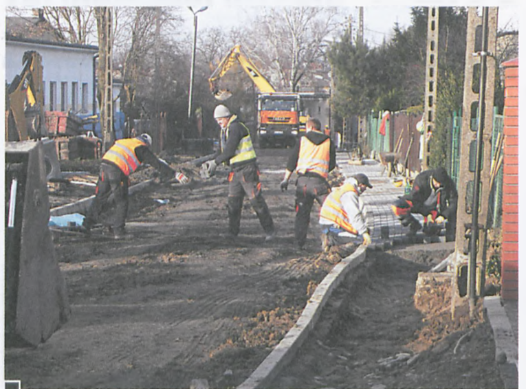
Układanie wąskiego chodnika od strony ul. Powstańców Wlkp. z pozostawieniem szerokiego pasa „zieleni” po lewej fot. Hanna Siatka
