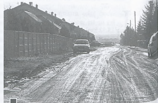
Ul. Nowiny w Żabikowie prowadząca do granicy miasta z Komornikami. Na polach położonych do niedawna po wschodniej stronie drogi (na zdjęciu – z lewej) powstały nowe osiedla, do których pieszo nie sposób dotrzeć „suchą nogą” fot. Hanna Siatka
