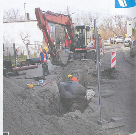
Układanie nowego systemu odwodnienia prowadzonego od Intermarkh, przez ul. Paderewskiego, do Krasickiego (na zdjęciu). W głębi ul. Puszkina i prace związane z włączeniem do Strumienia Junikowskiego fot. Hanna Siatka
