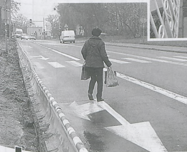
Mieszkańców ul. Paderewskiego odcięto też od jednego przejścia dla pieszych przez ul. Żabikowską. Z lewej budowa pasa drogowego na potrzeby Intermarkhe. Zdesperowany pieszy próbuje się przedostać na drugą stronę ruchliwej i szerokiej ul. Żabikowskiej fot. Hanna Siatka
