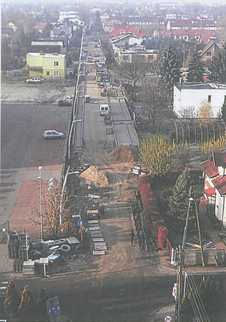
Budowa ul. Westerplatte z lotu ptaka. U dołu ul. Kołłątaja, z lewej – parking LOSiR i ciągnący się wzdłuż całej drogi rząd nowoczesnych, ledowych lamp. Po prawej, na szerszym odcinku drogi, widoczne miejsca postojowe (prostokąty pomiędzy jezdnią a chodnikiem) fot. Rafał Wojtyński
