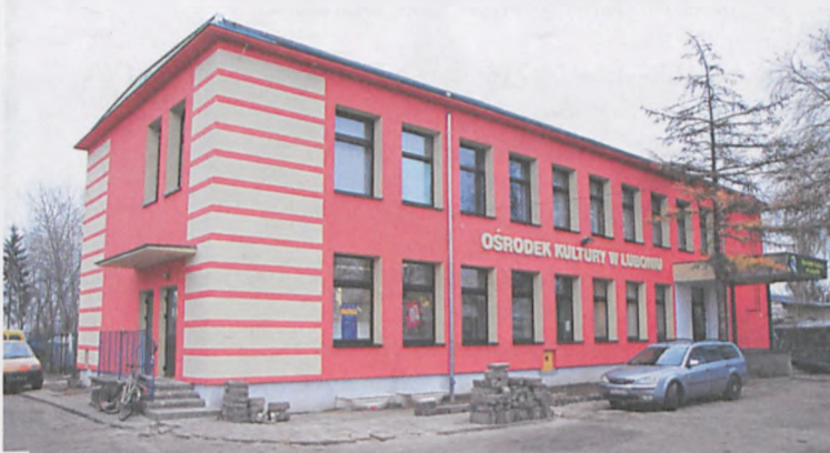
Po zakończeniu prac związanych z termomodernizacją w Ośrodku Kultury, wkrótce dobiegnie końca malowanie elewacji fol. Paweł Wolniewicz
