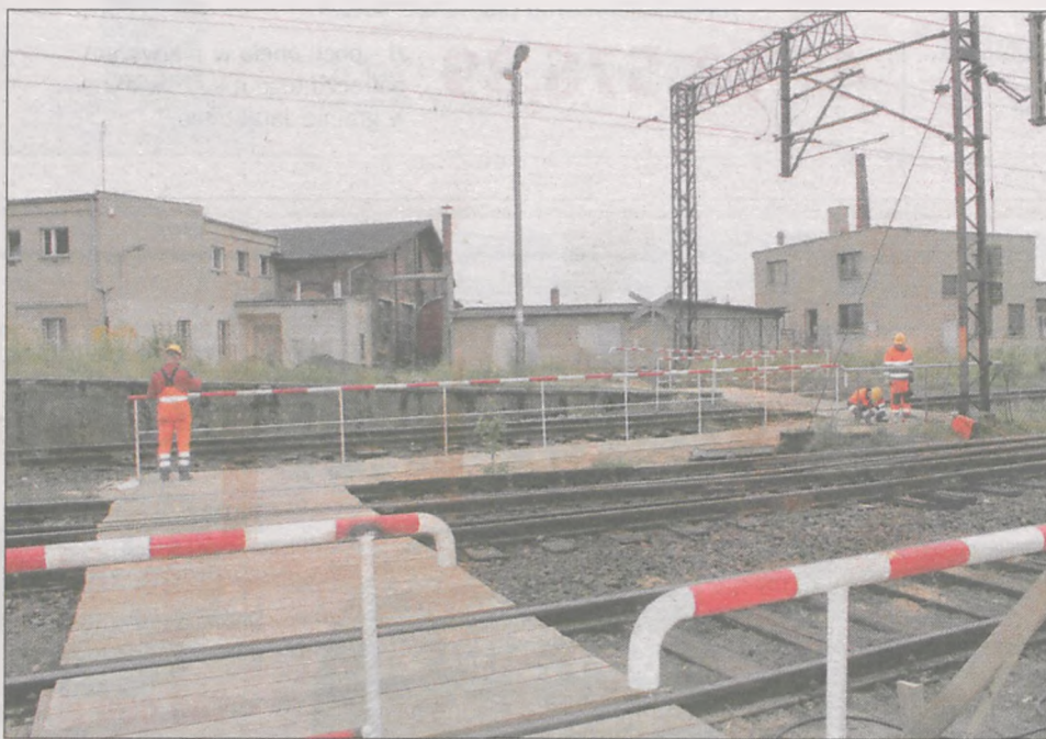
Oznakowane i zabezpieczone barierkami przejście wykonała firma Skanska, która przebudowuje jarocińskie wiadukty
