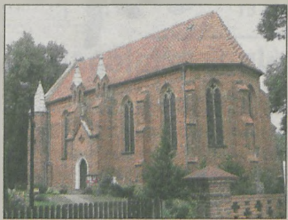
Gminna dotacja przeznaczona zostanie na wyremontowanie kościoła
