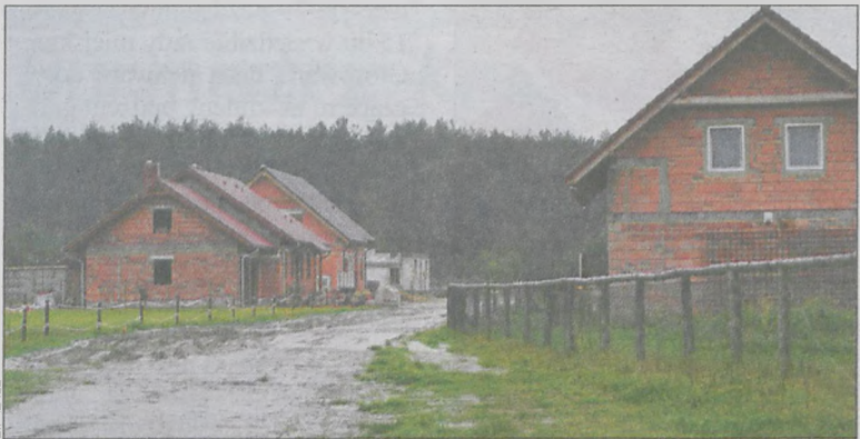
Tutaj będzie kanalizacja
