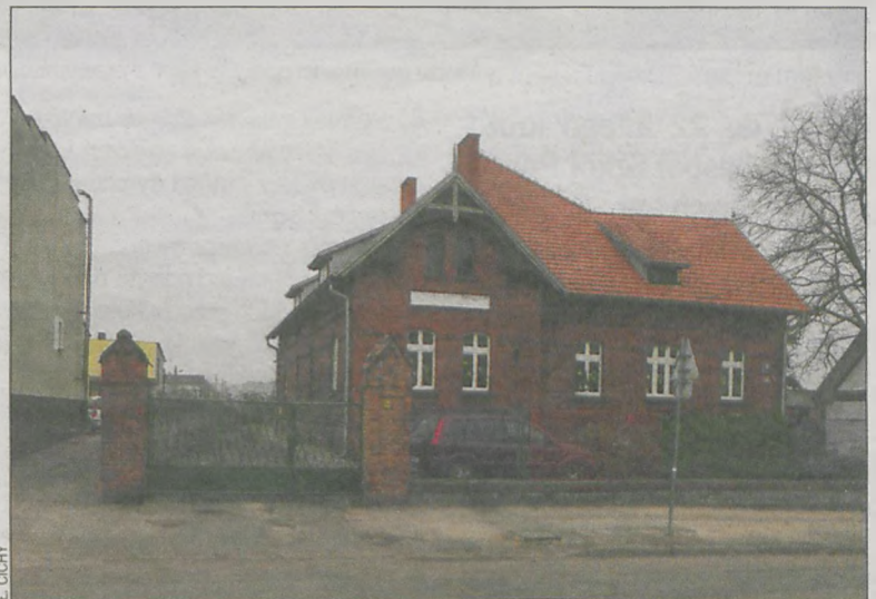
Wiosną zostanie utwardzony wjazd do przedszkola
