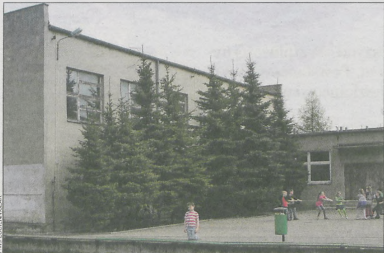
Najpierw trzeba zburzyć starą salę w „jedynce”, a potem zbudować nową
