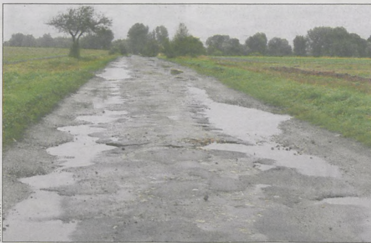
428 metrów odcinka tej drogi zostało zmodernizowane
