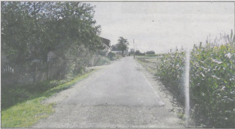
Tylko część drogi we wsi została przebudowana
