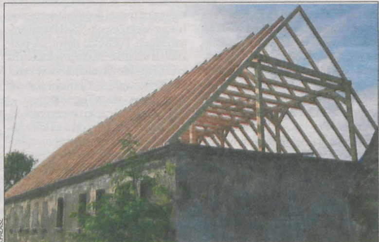
Drewniana więźba dachowa została już zamontowana
