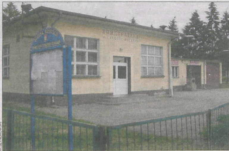
Świetlica w Zalesiu zostanie gruntownie zmodernizowana
