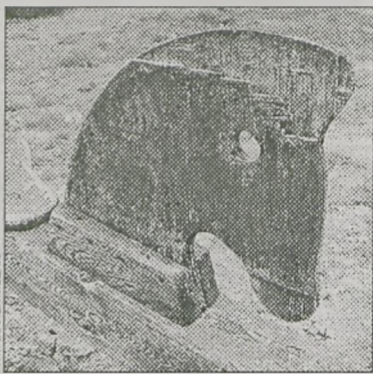
Niektóre urządzenia są zniszczone
