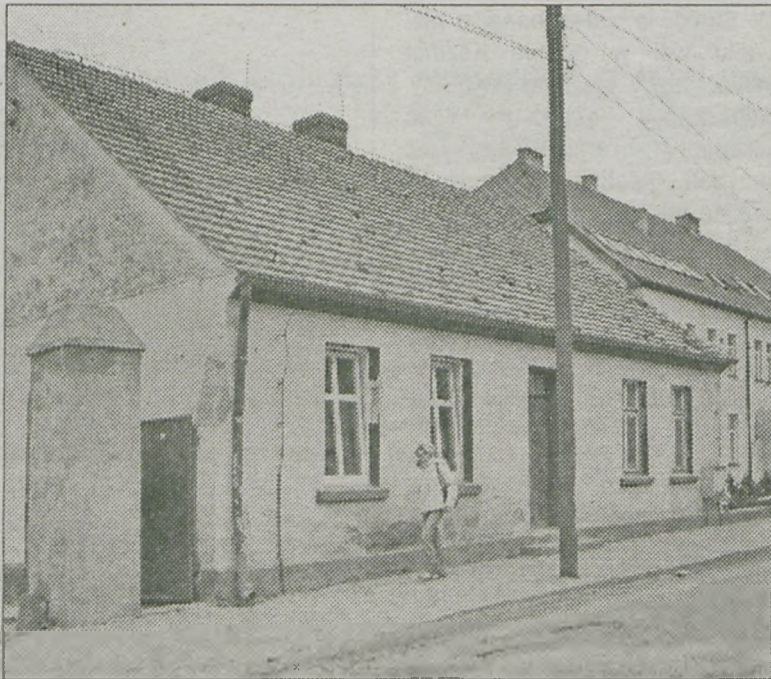
Budynek przy ul. Krobskiej jest jeszcze w trakcie remontu
