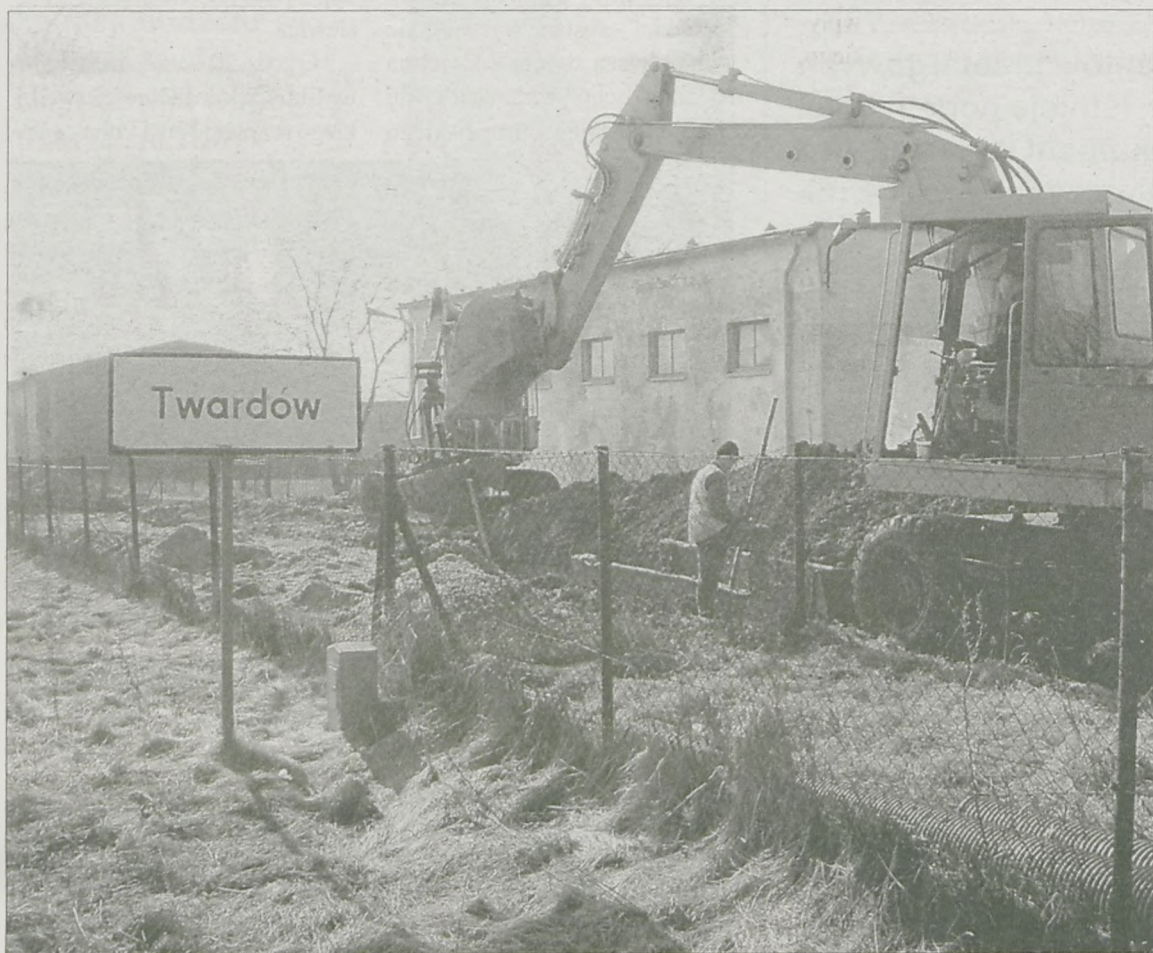
KANALIZACJA TWARDOWA rozpoczęła się w połowie marca. Zdaniem wójta Walentego Kwaśniewskiego zakończy się na końcu maja
