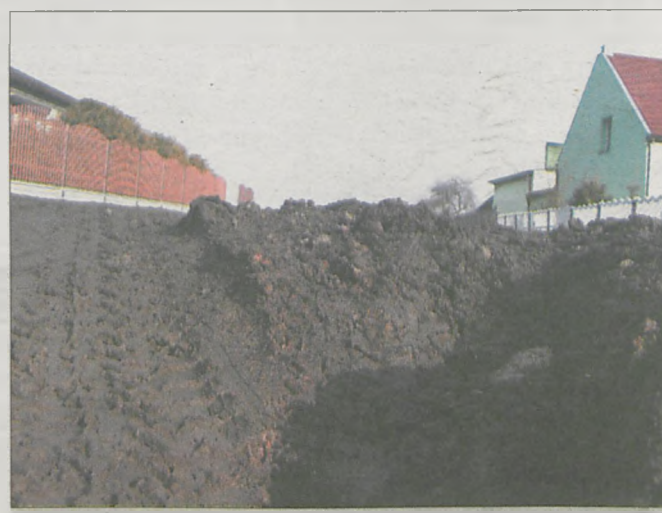
SKRZYŻOWANIE UL. OPŁOTKI (droga powiatowa) i Zakrzewskiej (droga gminna). Czyżby oba samorządy dzieliła taka przepaść?
