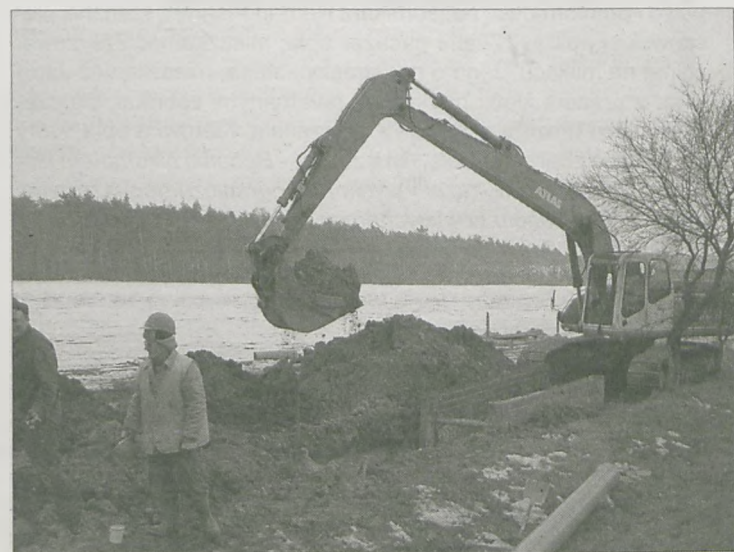
ZAŁĘGAJĄCY NA POLACH ŚNIEG i zamrożona ziemia nie odstraszyły ekipy budującej kanalizację w gminie Jaraczewo
