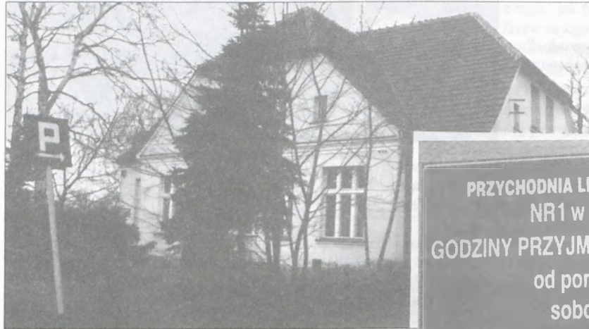
Budynek poradni rodzinnej przy ul. Okrzei
