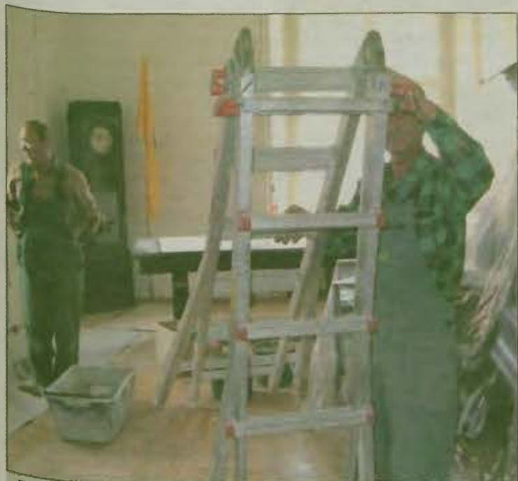
REMONT w ratuszu rozpoczął się od wymiany instalacji elektrycznej
