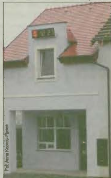
NA ELEWACJI nowego obiektu umieszczony został zegar, który wskazuje godzinę i temperaturę
