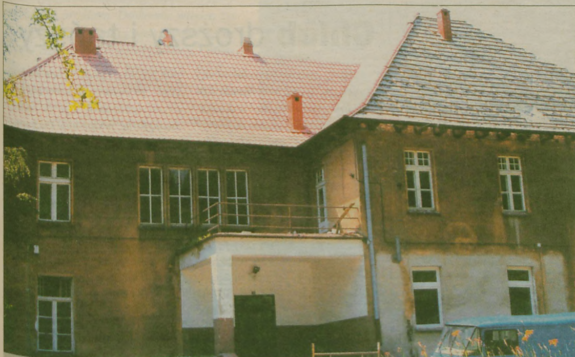
REMONT SZKOŁY W GOLI jest największym przedsięwzięciem w historii placówki. Pochłonie ponad 460 tys. zł. Obecnie na budynku szkoły wymieniany jest dach
