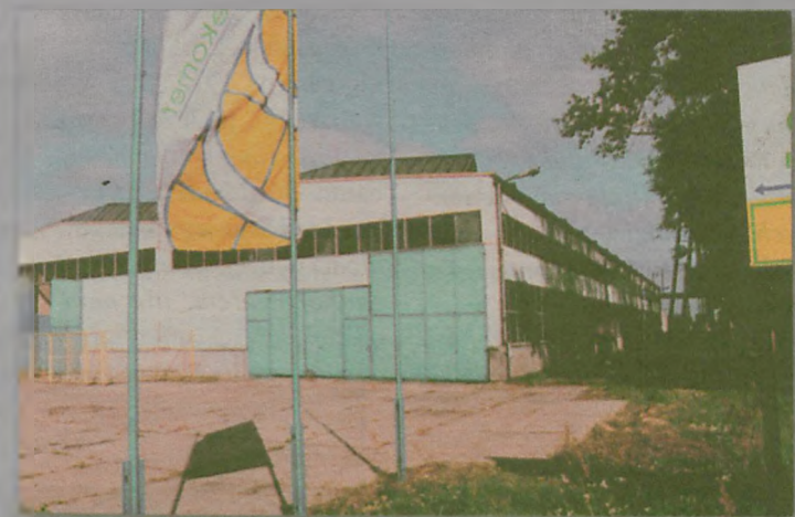
Przykładowa hala z przeznaczeniem do zagospodarowania Halle destinée à aménager
