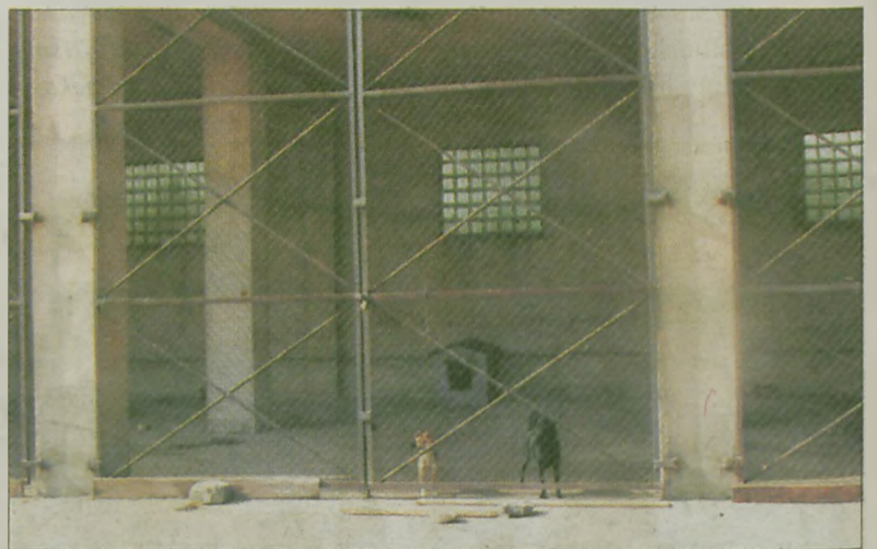
Na potrzeby schroniska przekazane zostały budynki po byłej spółdzielni rolniczej w Radlinie: dwie wiaty po kombajnach (na zdjęciu), dziesięć garaży oraz pomieszczenia po warsztatach z zapleczem socjalnym
