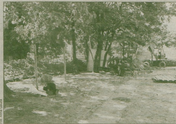
Rozpoczęły się prace budowlane przy jarocińskiej „dwójce”. Powstanie tam sala gimnastyczna. Wykonawcą inwestycji jest krotoszyńskie Przedsiębiorstwo Ceramiki Budowlanej „CERABUD” S.A. Koszt budowy hali sportowej to ponad 3 mln zł. Zakończenie prac planowane jest na koniec lipca przyszłego roku. Wmurowanie kamienia węgielnego pod salę nastąpi 31 maja o godzinie 16.00
