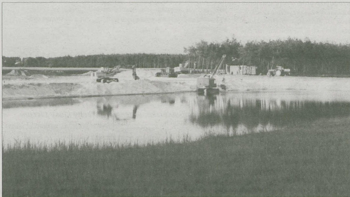
W prawidłowo prowadzonych żwirowniach teren po eksploatacji zostaje odpowiednio zrekultywowany. W miejscach wyrobisk powstają np. stawy rybne
