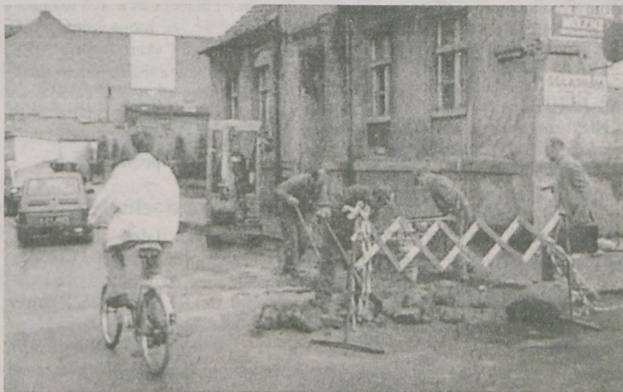
Jesienią na ulicach w centrum miasta prace ziemne wykonywać będzie Telekomunikacja Polska S. A. Fot. R. Kaźmierczak
