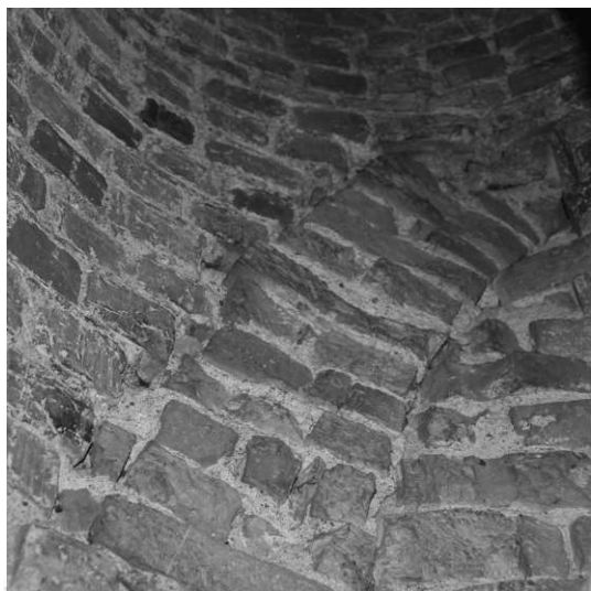
6a. Relikt łuku konstrukcyjnego w zachodniej części wieżyczki schodowej
