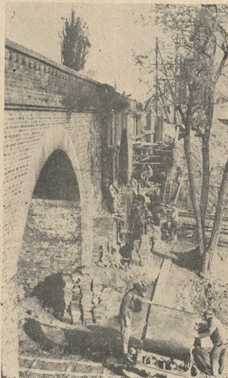
Roboty przy poszerzaniu mostu na Dębcu.
