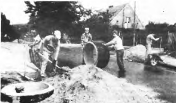
Prace przy budowie kanalizacji na Osiedlu 700-lecia
