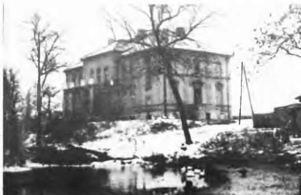
Pałac w Orpiszewku (stan obecny)
