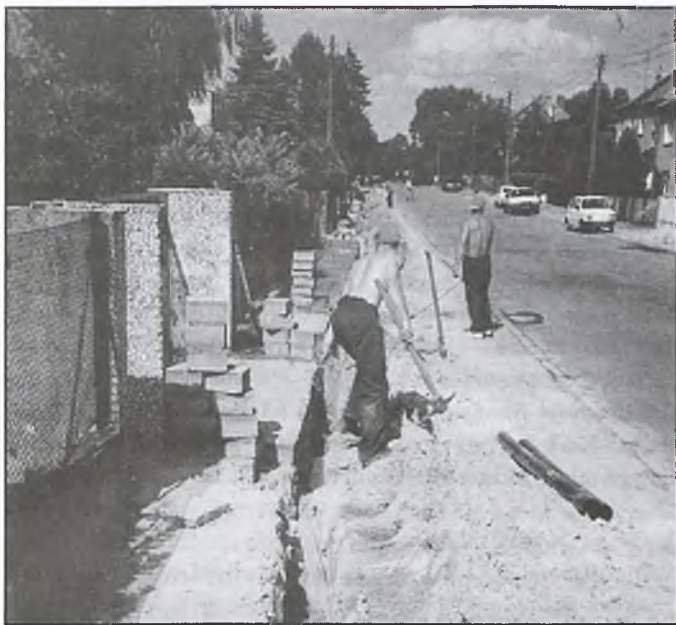
Prace przy ul. 3 Maja
