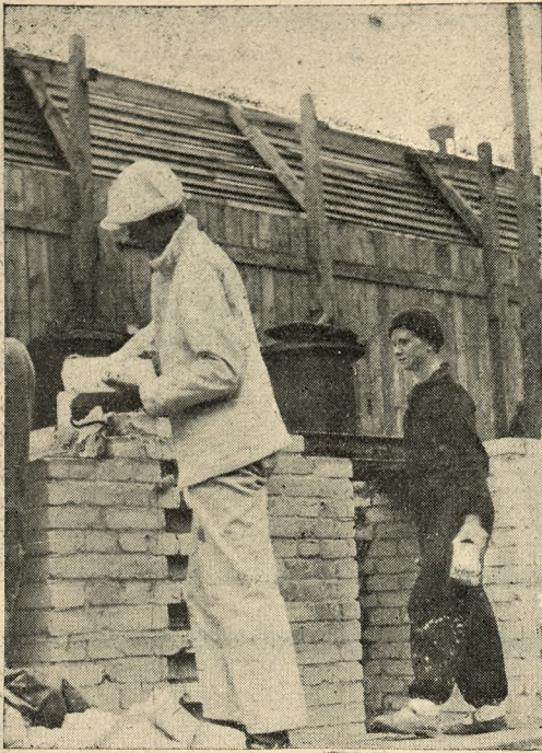
Tak się kładzie cegły.
