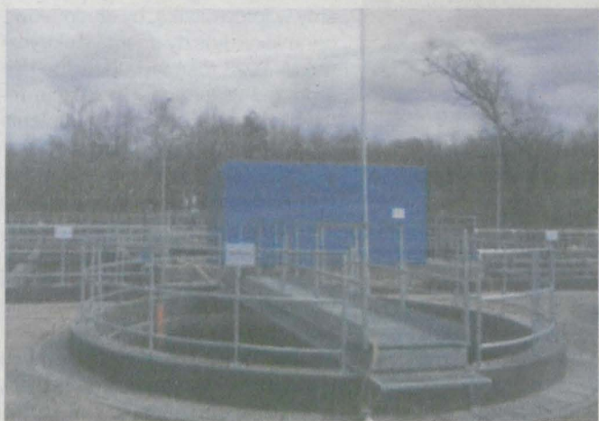
Rozbudowa oczyszczalni ścieków w miejscowości Wyszki (etap II)
