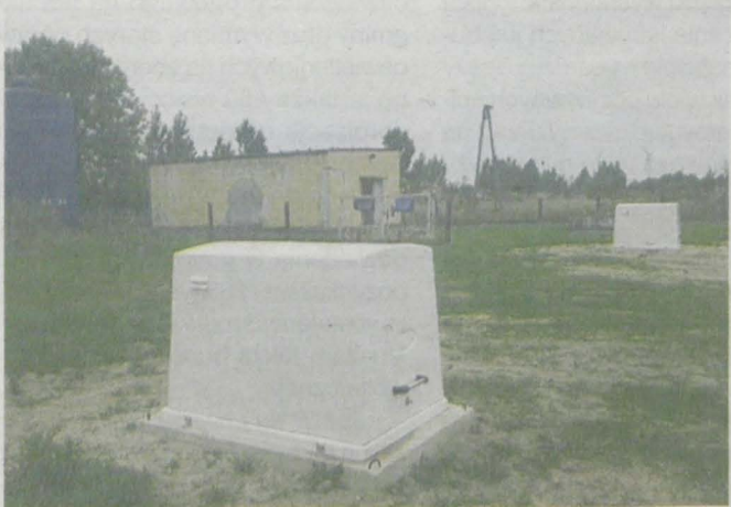
Budowa stacji uzdatniania wody w Kotlinie i Magnuszewicach
