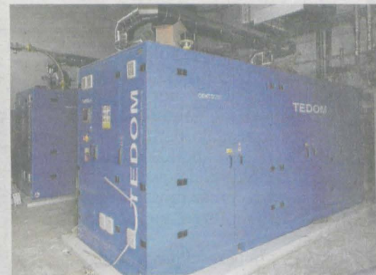
Kogenerator do produkcji energii elektrycznej i energii cieplnej
