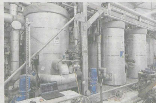
Instalacja termicznej obróbki osadu
