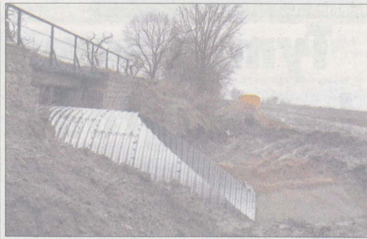
Most przygotowany jest już do remontu, prace trwają tu już od kilku tygodni.
