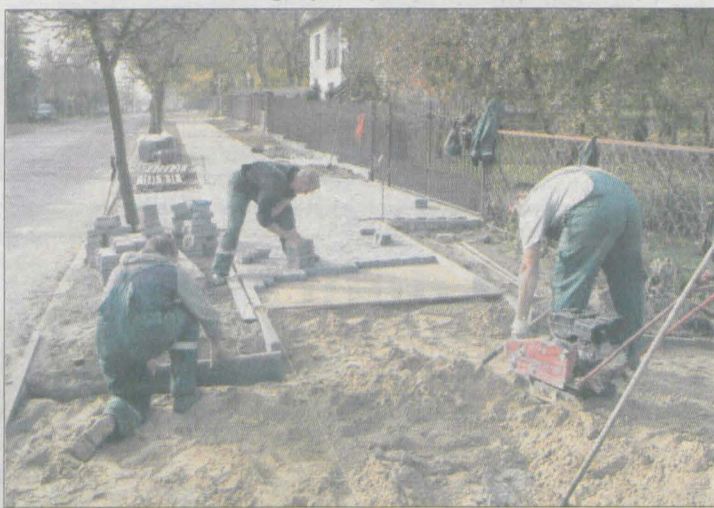
Remont polega na wymianie
