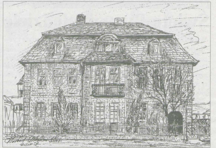
Rzeźnia powstała w 1915 roku. Co będzie w przyszłości z zabudowaniami przy ul. Kilińskiego? Ciągłe nie wiadomo. Rys. Norbert Malinowski (norbert_malinowski@op.pl)
