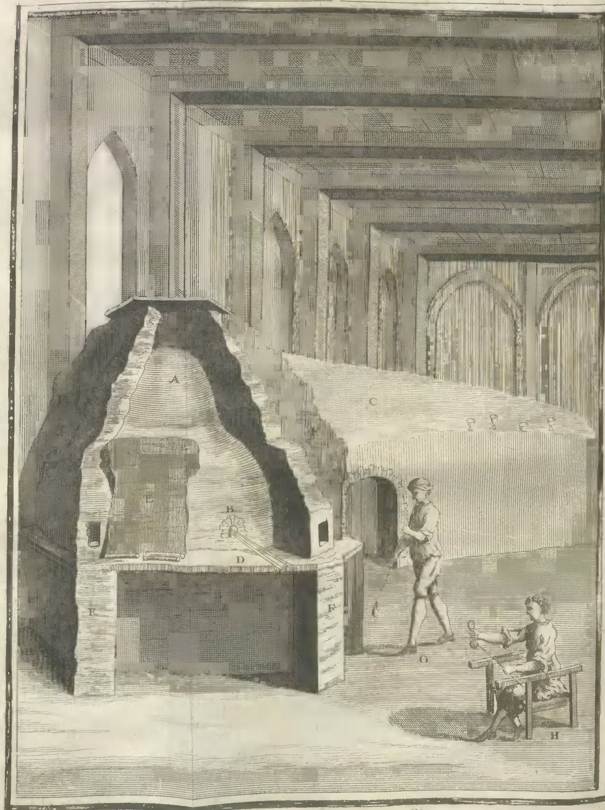
Ancien Fourneau de Verrerie à l'Italienne
