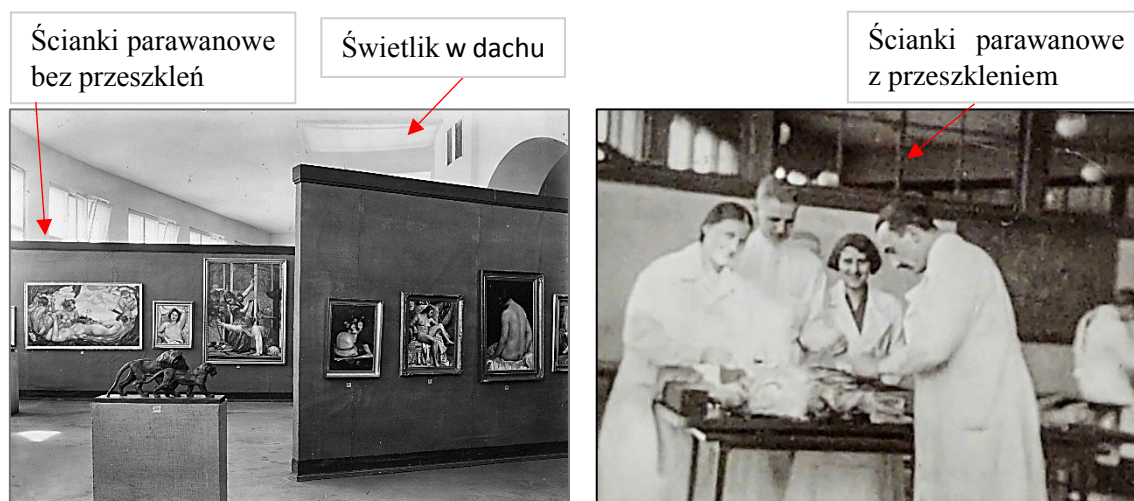
Ryc. 22. Wystawa Towarzystwa Artystów "Sztuka" z Krakowa, w Pałacu Sztuki, podczas PWK w 1929 r., zorganizowana w przestrzeni prosektorium gmachu Anatomii. Widoczne ścianki parawanowe bez przeszkleń oraz jeden z ośmiu świetlików, w dachu. Zbiory Miejskiego Konserwatora Zabytków w Poznaniu, fot. Roman Ulatowski.
