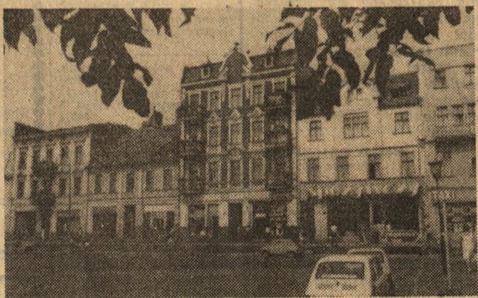
Choć wolno postępuje renowacja zabytkowych kamienic w śródmieściu Gniezna, to jednak pierwszy etap związanych z tym prac niedawno zakończono. Niektóre budynki w centrum sporo zyskały dzięki konserwatorom.
