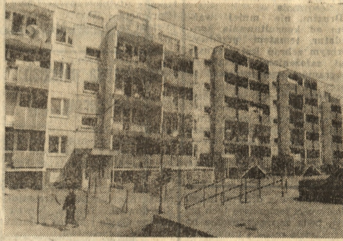
Jednym z wyróżnionych w tym roku budynków jest obiekt postawiony przez Kombinat Budowlany Poznań-Wschód na Osiedlu ZWM 23—28 w Poznaniu.
