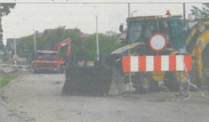
Trwa remont skrzyżowania ul. Poselskiej i Hallera.
