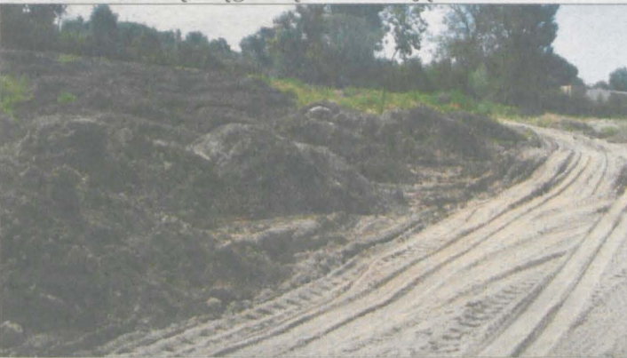
Na terenie po basenach ma powstać nowoczesny obiekt rekreacyjny.
