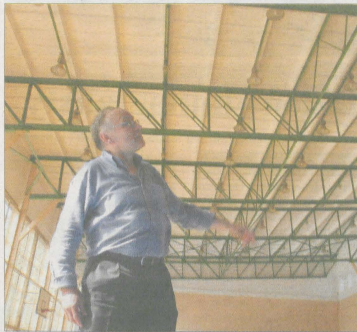
Dach w hali Gimnazjum nr 1 był od początku felerny. Dlatego dyrektor A. Gniotowski jest zadowolony, że dach zostanie wreszcie wymieniony.
