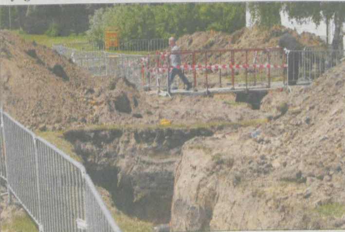
Budowa ciepłociągu rozpoczęła się koło samy na Osiedlu Jagiellońskim.
