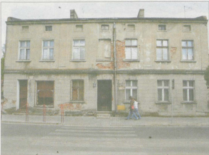
Kamienica przy ul. 20 Października
