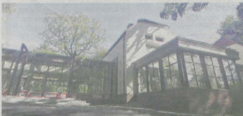
Jeśli wszystko pójdzie zgodnie z planem, wiosną przyszłego roku stylowy kompleks kawiarniano-restauracyjny w jarocińskim parku będzie gotowy
